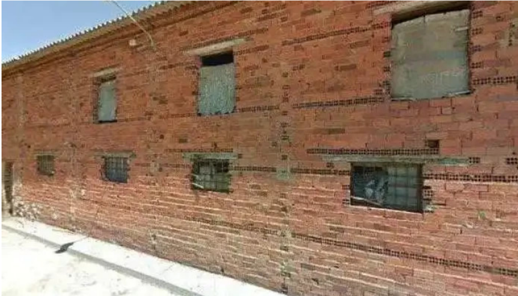
Iglesia de villaturde iglesia
