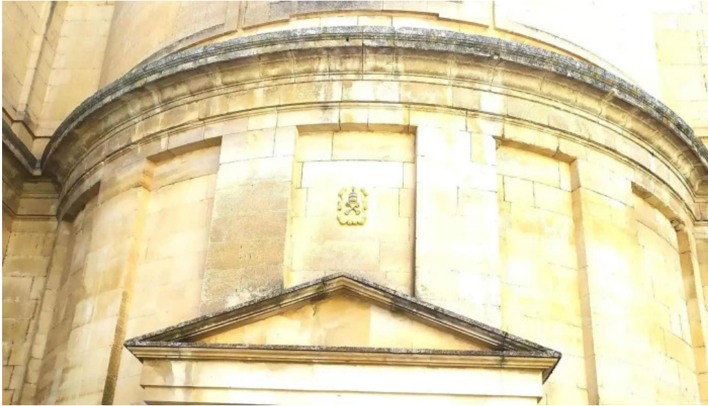
Iglesia monastica de san sebastian santo domingo de silos
