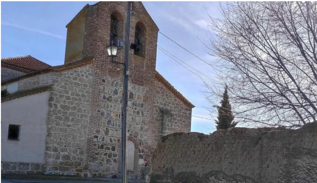
Iglesia de santo domingo de las posadas santo domingo de las posadas
