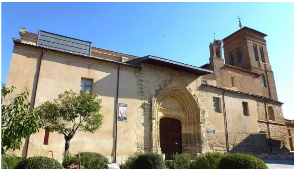
Iglesia de san martin paredes de nava
