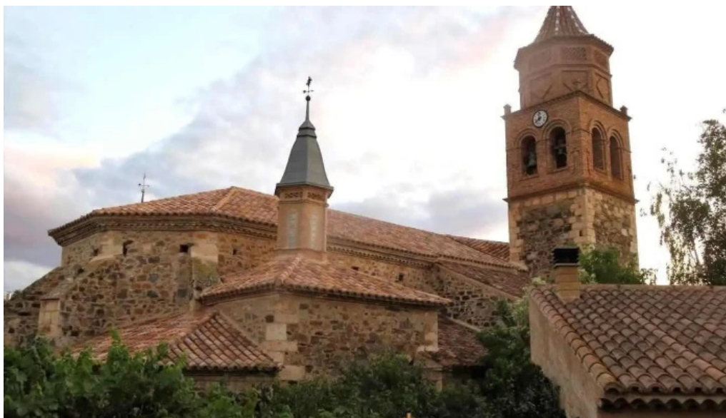
Iglesia de la asuncion de luco del jiloca luco de jiloca
