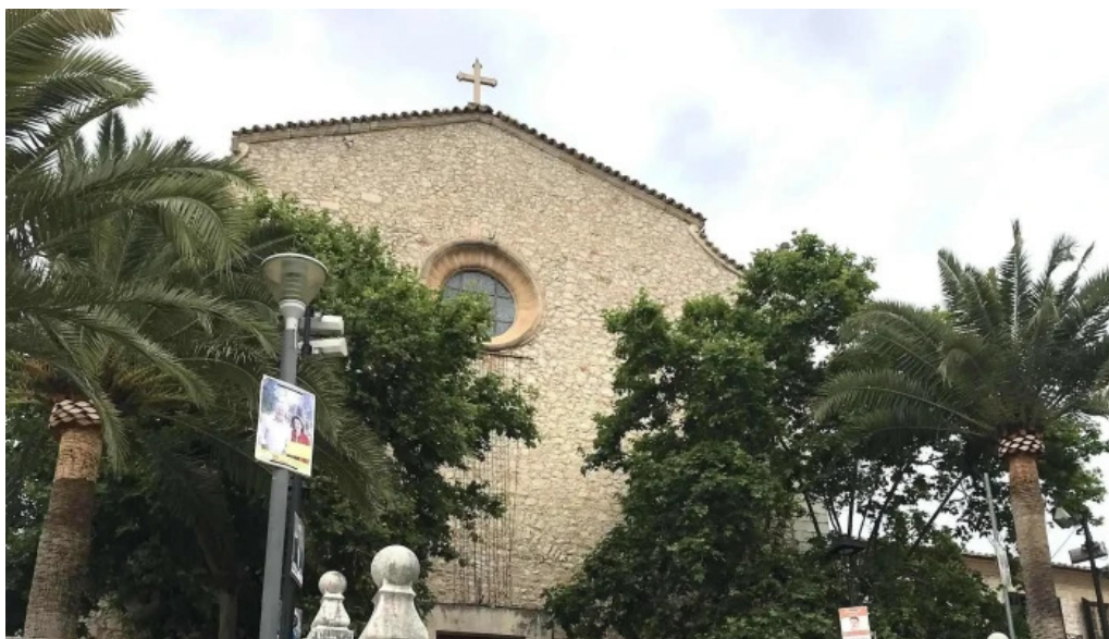
Iglesia de Iloseta Iloseta
