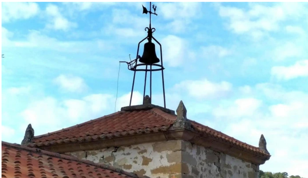
Iglesia de la visitacion iglesia
