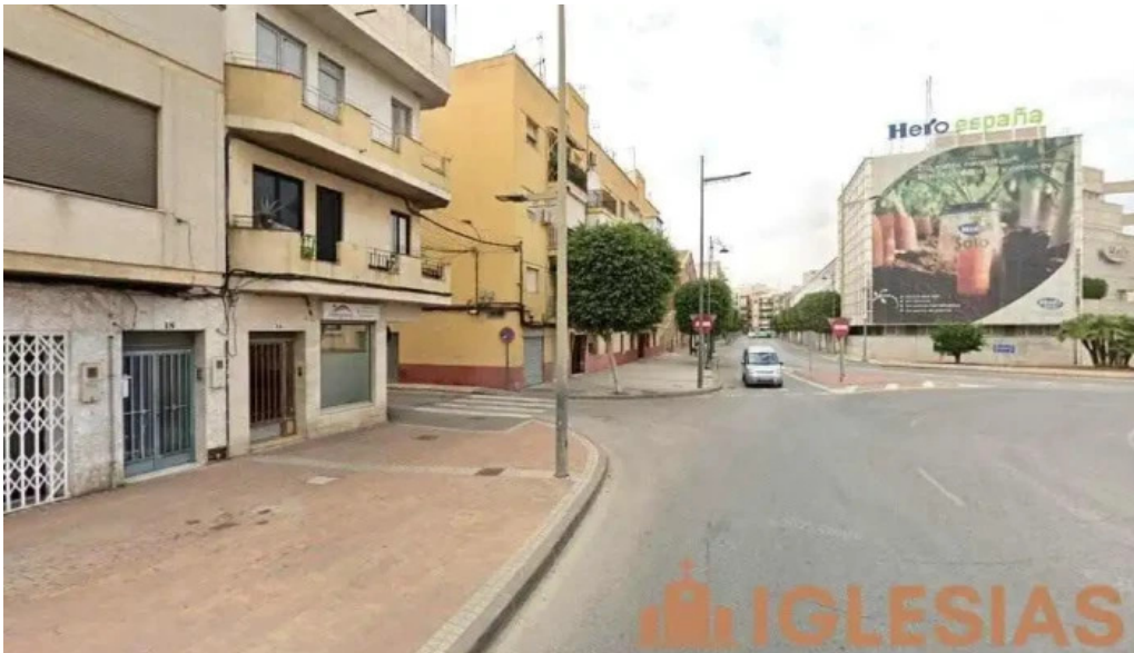
Ipue tabernaculo de vida alcantarilla alcantarilla
