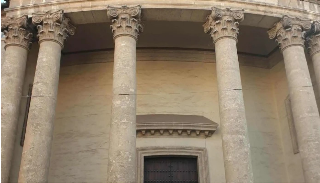
Iglesia de santa victoria puntaje
