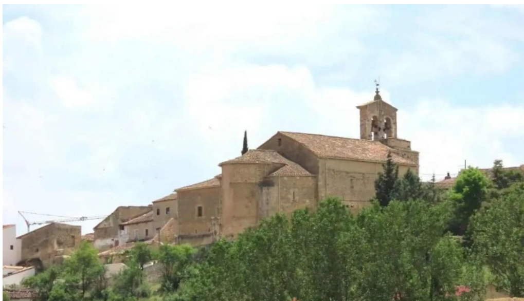
Iglesia de santo domingo de silos carboneras de guadazaon
