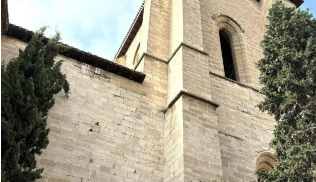
Iglesia de santa maria la real y antigua opiniones
