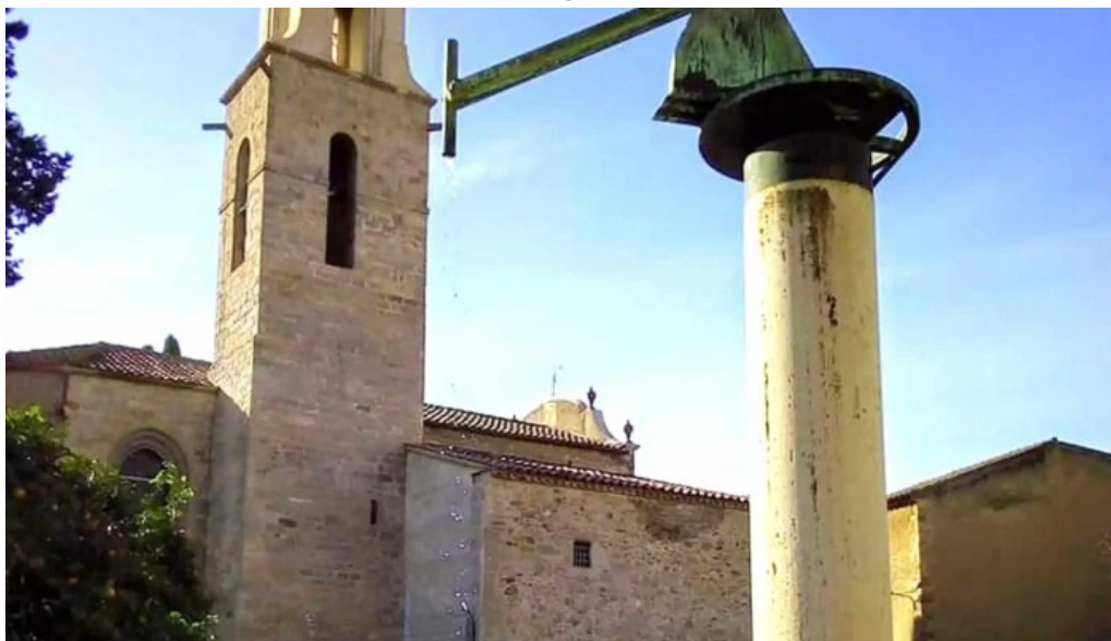
Iglesia de san martin de provensals zona
