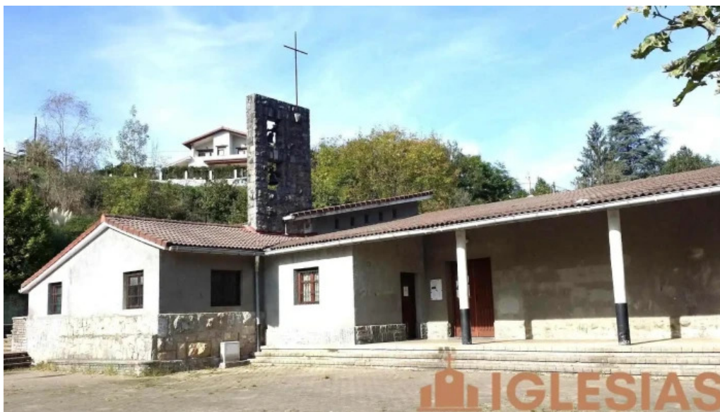
Iglesia de san ignacio de ambasaguas la estacion ambasaguas
