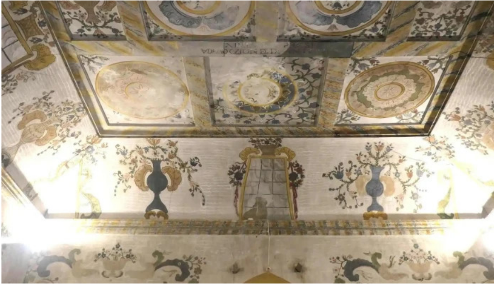
Ermita de santa lucia y san roque tarazona de la mancha
