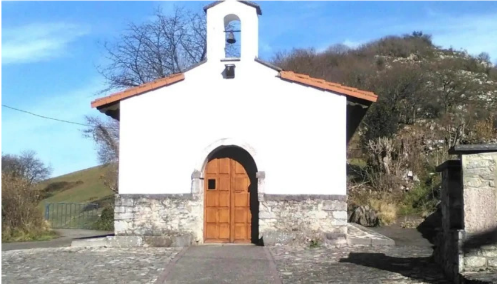
Capilla del santo angel de laguarda la mortera capilla
